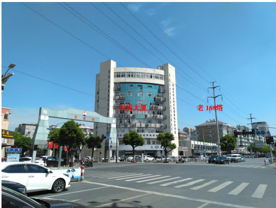
兴禹大厦照片
