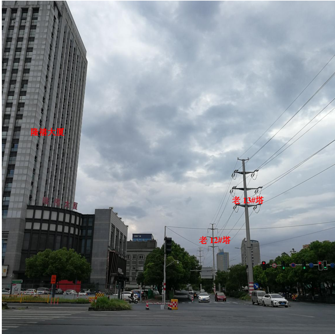
隆禧大厦现状照片
